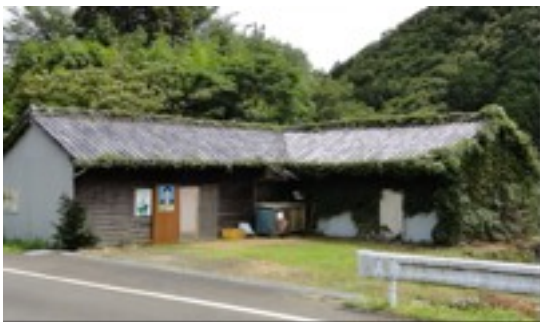
（写真② 水車小屋全景）
